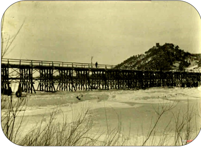
Fotografia archiwalna. Most na Dunajcu pod Melsztynem, rozebrany w roku 1978. Po prawej stronie widnieje wzgórze z ruinami zamku Spytków i Leliwów w Melsztynie. W tym miejscu, zgodnie z obietnicą władz Miasta i Gminy Zakliczyn, w miejsce rozebranego mostu ma być wybudowana kładka turystyczna dla pieszych i rowerzystów, łącząca Wesołów z Melsztynem.
