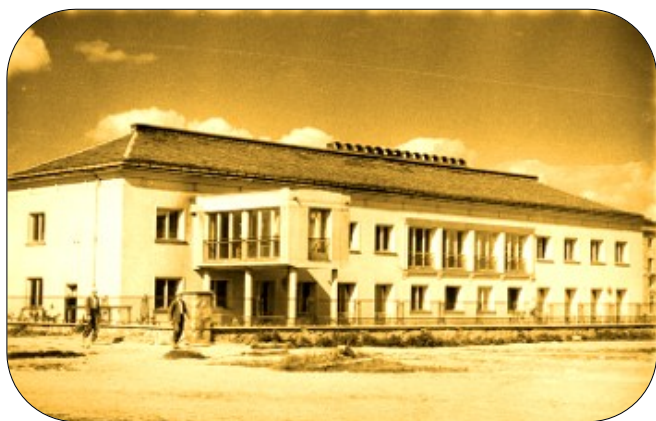
Fotografia archiwalna. Budynek w os. „Na Skarpie” 27, w którym w latach 50.XX wieku funkcjonował tygodniowy żłobek.
